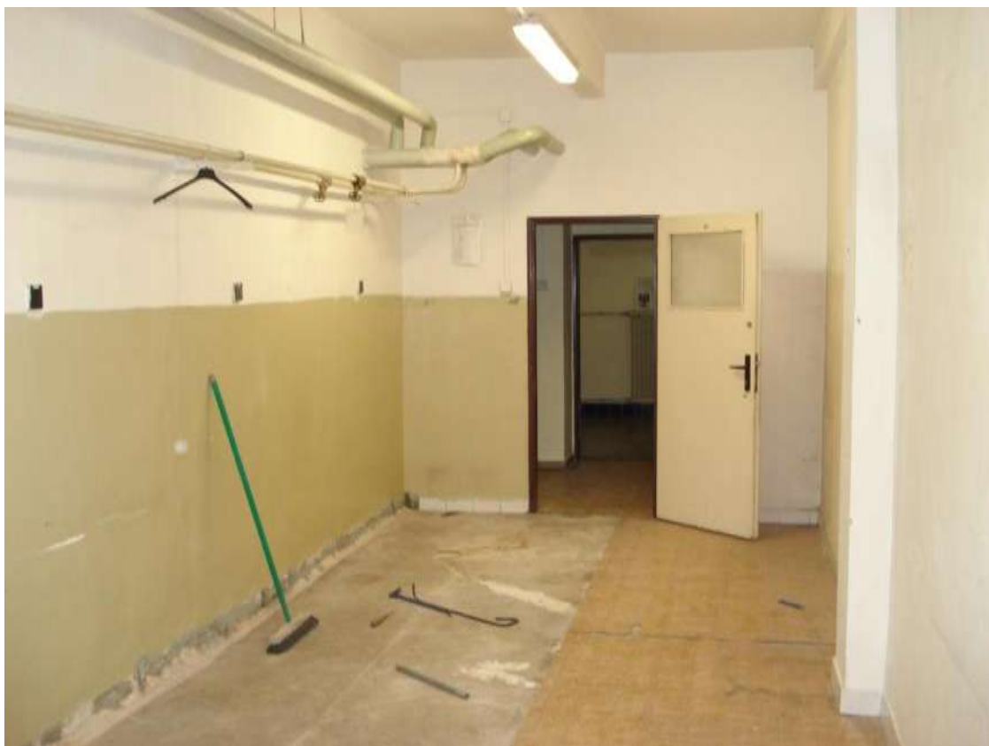
Šatna uklízeček před opravou
