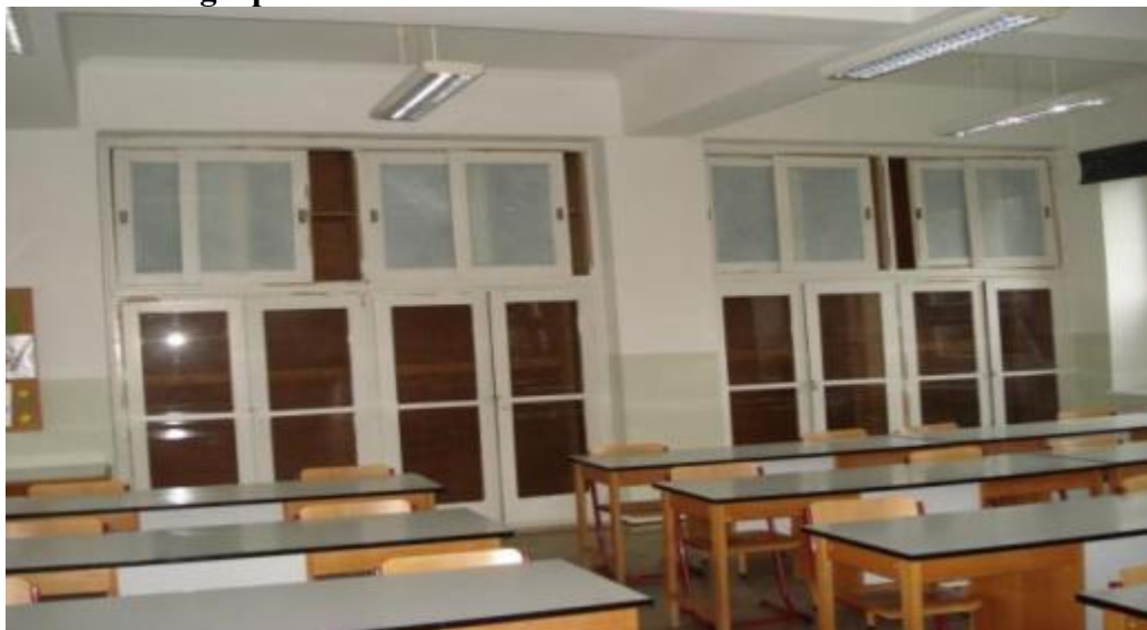
Učebna biologie před rekonstrukcí
