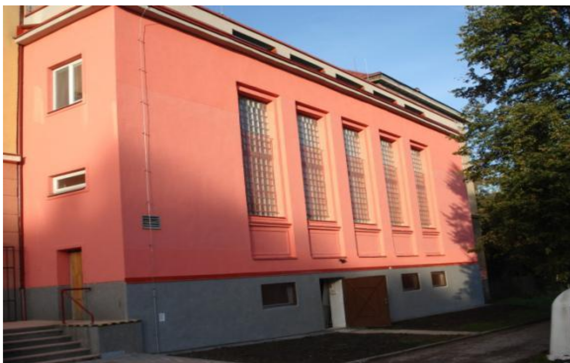
Spojovací budova s tělocvičnou po opravě a před ní
