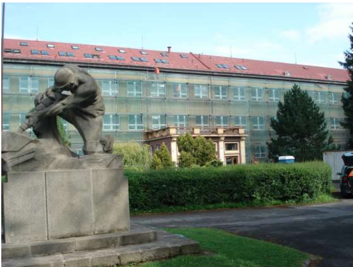
Obrázek 36: Počátek oprav fasády školy – červen 2018
