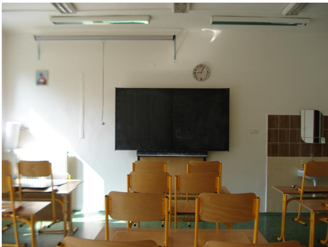
Dokončení instalace pylonových tabulí – kmenové třídy v I. a II. patře (původní a nový stav)
